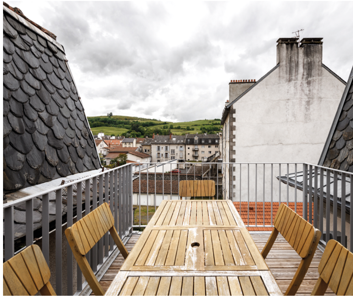
Logements, Aurillac © Benoît Alazar Photographe
